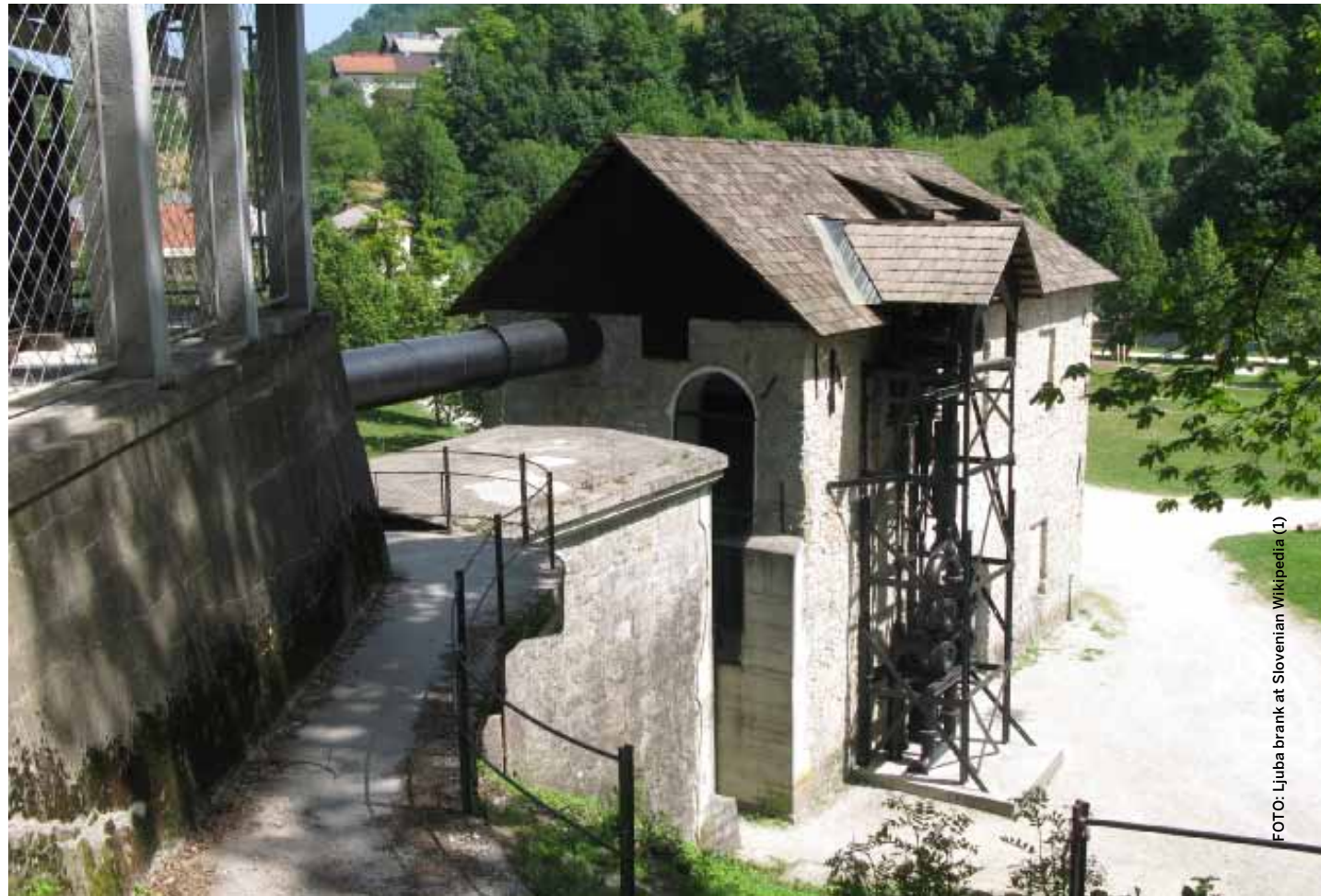
TECHNIK Die Wasserförderanlage Kamst (Wasserkunst), mit dem bestens erhaltenen Riesenholzrad von 1790, konnte pro Minute 300 Liter Wasser an die Oberfläche pumpen.
